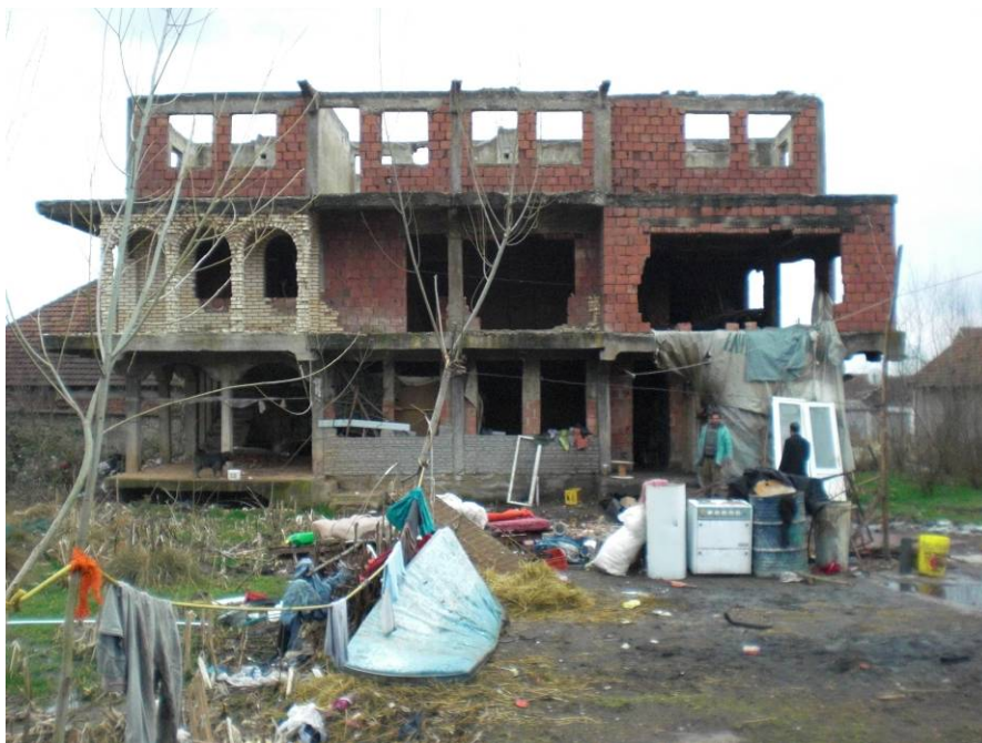
In der Nachbarschaft leben Roma auch in Holzhütten oder zerstörten Häusern wie diesem, ohne Wasser, Heizung und Strom. Ein Schicksal, das auch Familie Sala befürchtet, wenn sie demnächst das Haus von Herrn Jemal verlassen muss.
